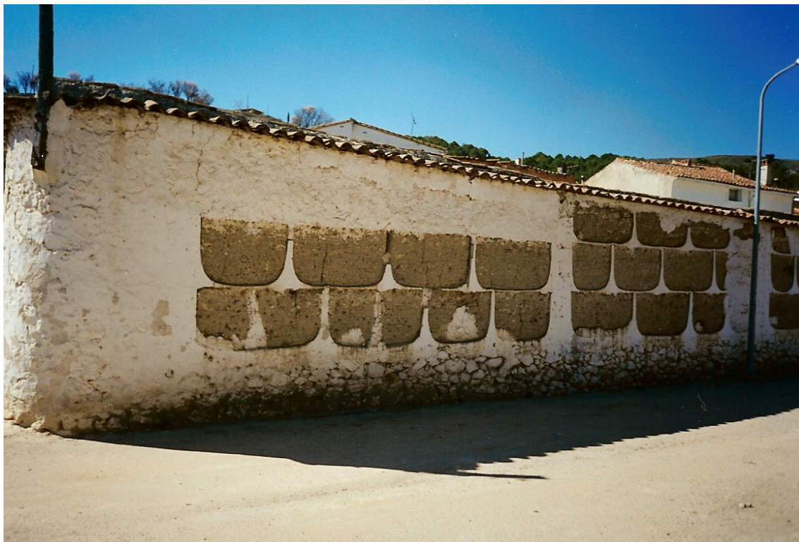
Tapial de adobe. "... los edificios de esta villa son de piedra y tapia de tierra y yeso y maderas de olmo y saces, y todo se cría y halla en esta dicha villa y su término". Relaciones histórico-geográficas de Felipe II en 1.576.
